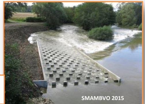
Rampe d'enrochement, Voray-sur-l'Ognon
